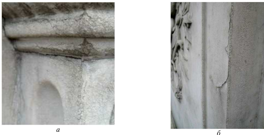
Рис. 6. Отшелушивание, выкрашивание ( а ) и отслаивание ( б ) на каррарском мраморе. Памятник М. В. Ломоносову. Фото 2011 года
